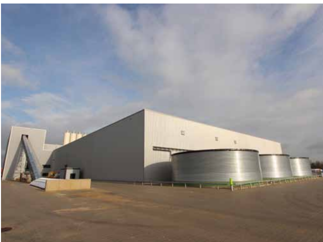
Панорама завода по производству мелкоразмерных бетонных изделий
