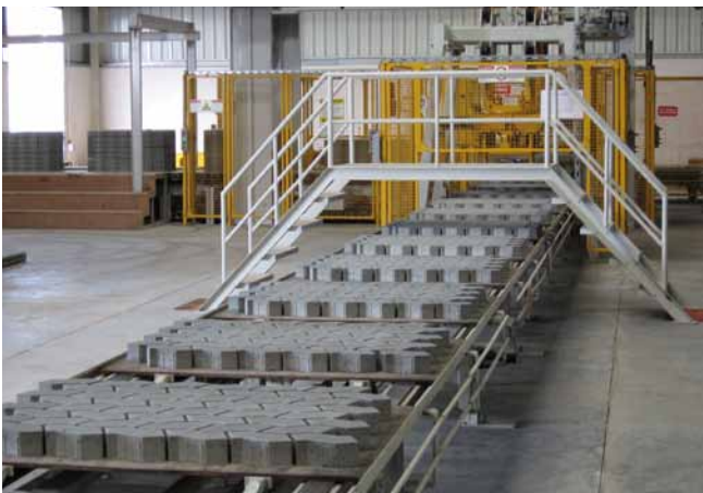
Транспортировка мелкоразмерных бетонных изделий
