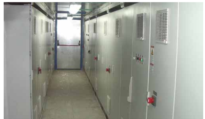
Силовые шкафы в контейнере Powertainer
