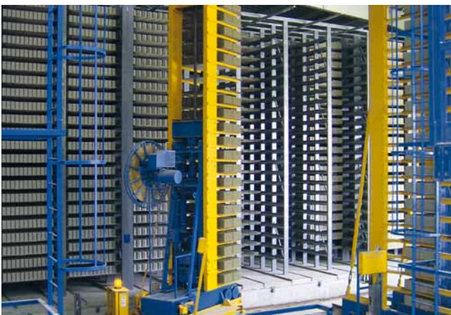
Загрузка камер набора прочности при помощи автоматического вилочного погрузчика
